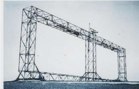
Eisenkonstruktion der ehemaligen Sendeanlage
